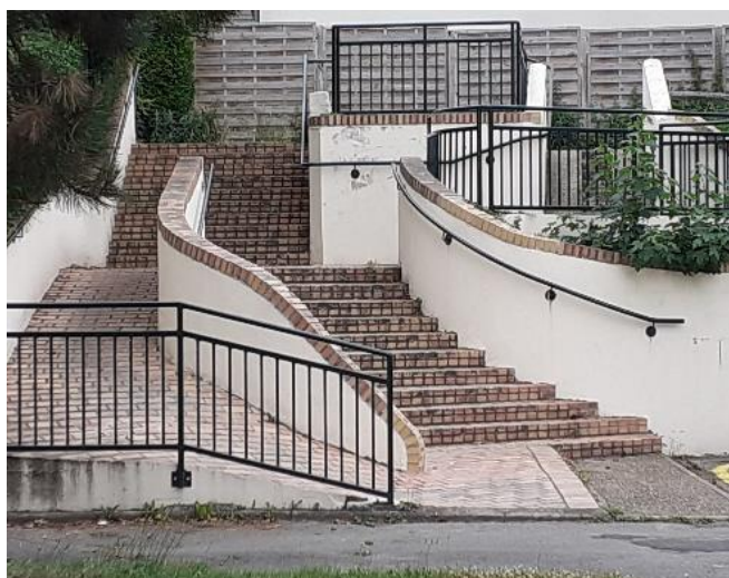
Rénovation de l'escalier reliant le haut du quartier aux écoles
